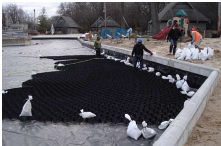
Installing the geomembrane.
